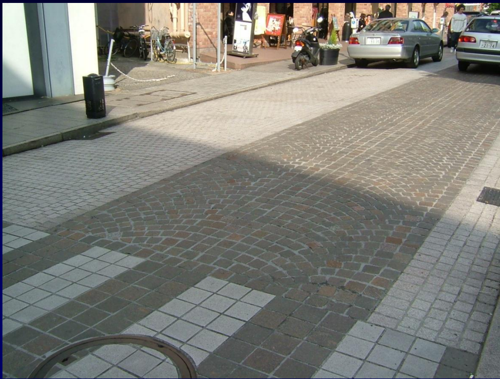
商店街の道路整備
